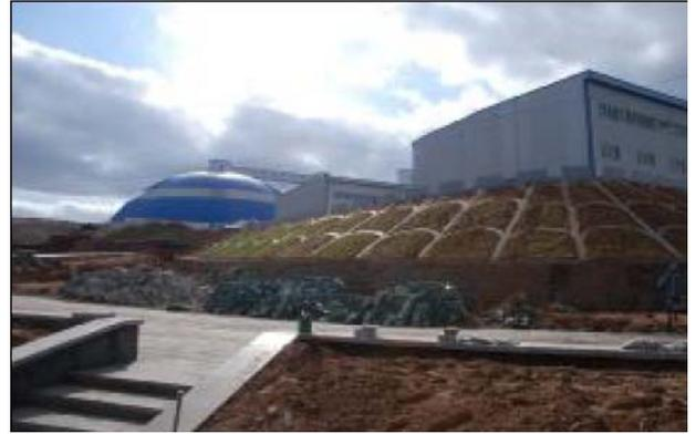
名称：工业场地拱形骨架护坡（柠条塔煤矿）
