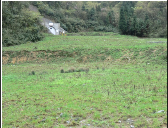
路通坝隧道出口渣场
