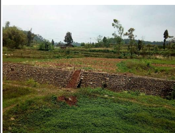
涪江钻爆隧道进口渣场
