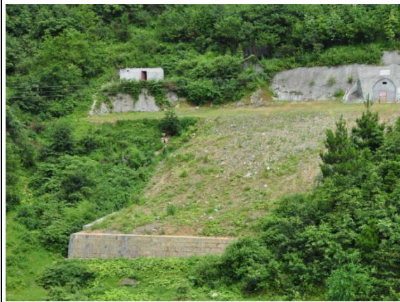
蔡家院子隧道渣场进口
