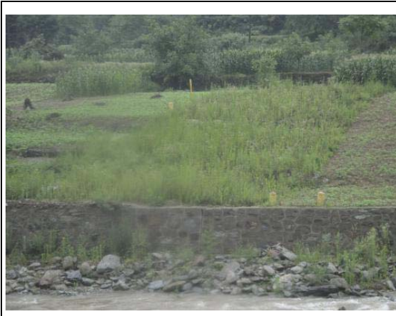
岩韭山隧道出口渣场 1#
