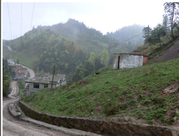
尖山子隧道出口，东斗山隧道进口共用弃渣场
