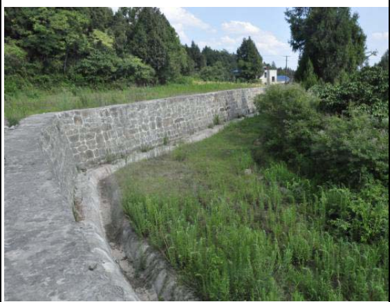
嘉陵江隧道穿越出口渣场
