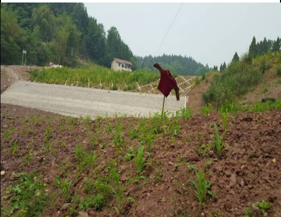
涪江钻爆隧道出口弃渣场
