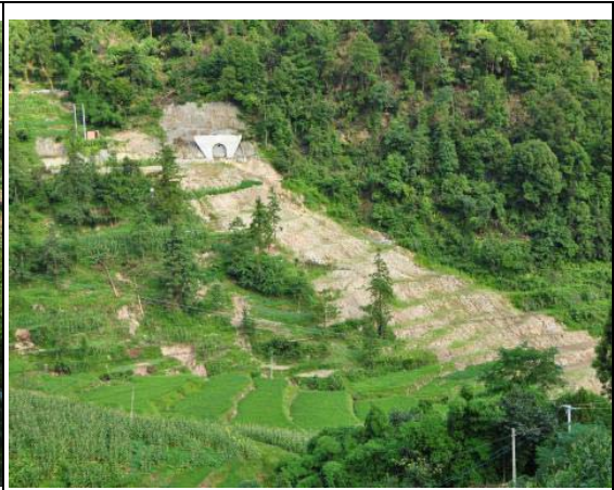
菁角隧道进口渣场
