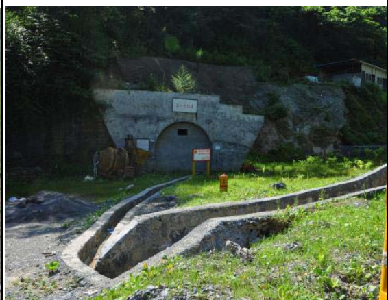
娄山关隧道进口渣场
