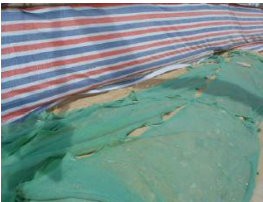
临时堆土防护网苫盖
