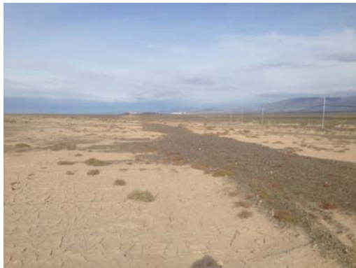
水源井供水管线
