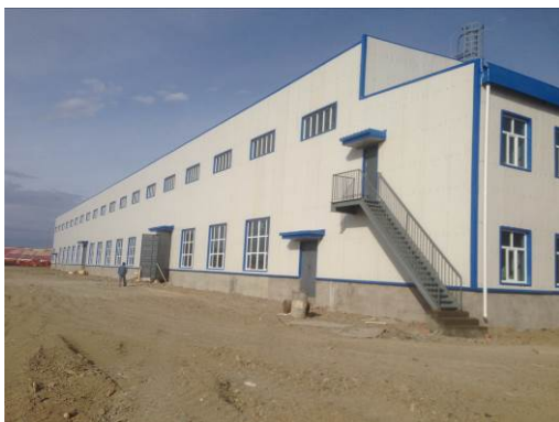
矿井修理车间
