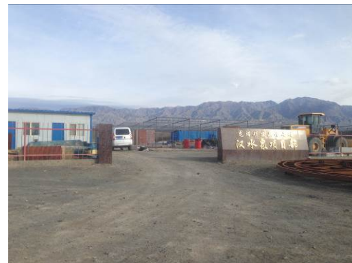
施工生产生活区
