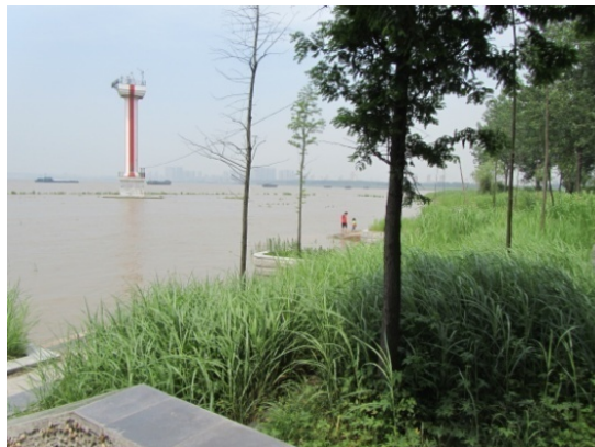
照片 4：堤防现状
