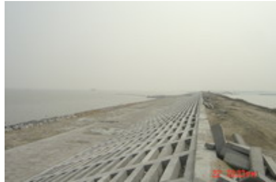
照片 6：外边坡预制混凝土栅格护坡
