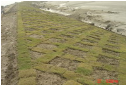
照片 7：内边坡草皮护坡
