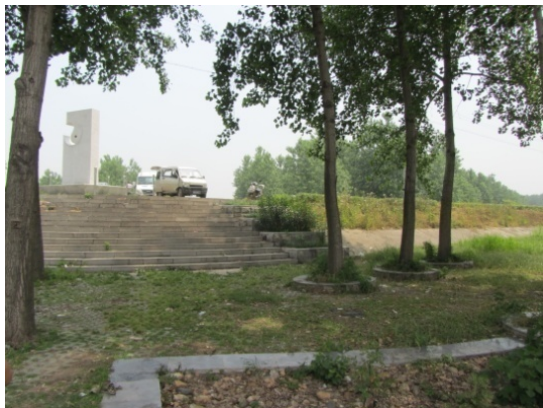
照片 3：堤防现状
