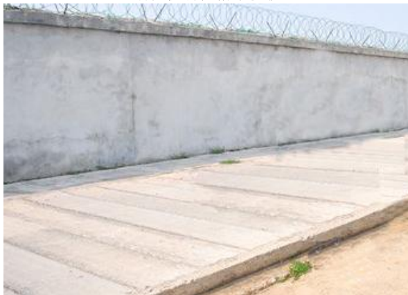
铜仁机场飞行区排水沟
