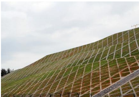
铜仁机场框格梁护坡
