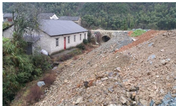
1#弃渣场排水过路涵
