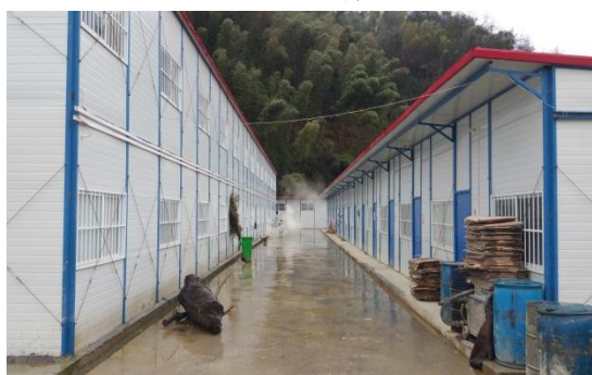
施工生活区排水
