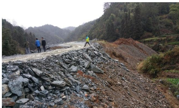
1#弃渣场堆渣现状
