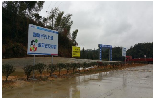
施工场地绿化
